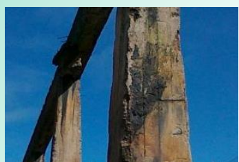
Carbonatación, corrosión por cloruros
