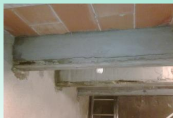
Presencia de humedad
