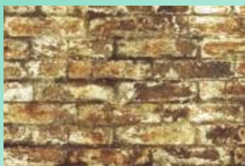
Contaminación: polvo, suciedad
